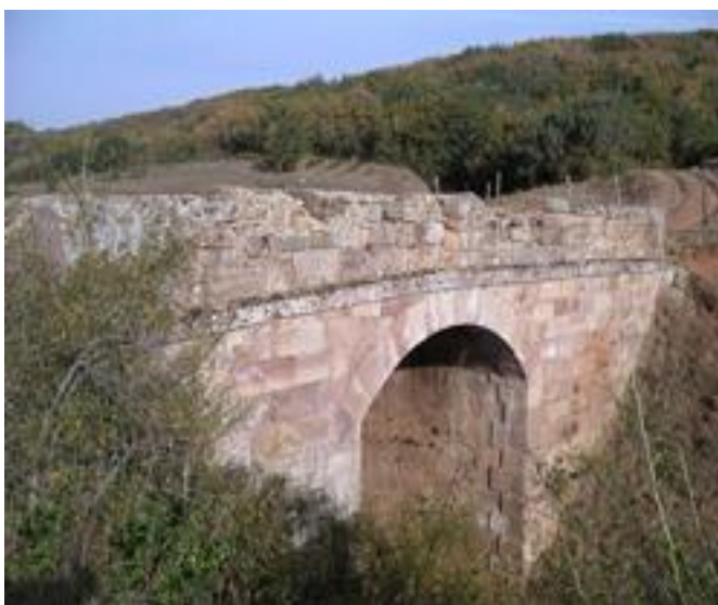
Puente Contadero sobre la antigua vía férrea.
